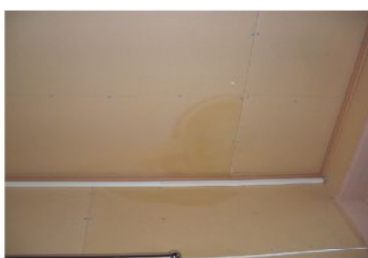
天井材撤去前
